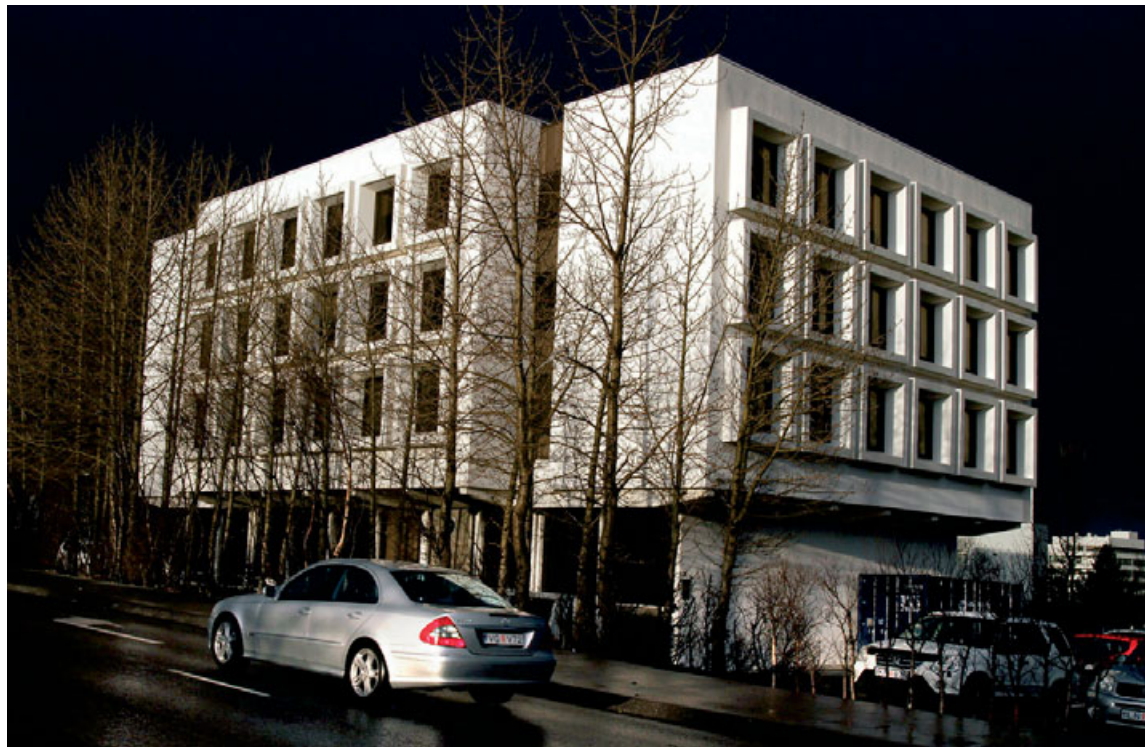
Erindi hefur verið sent miðstjórn Sjálfstæðisflokksins þar sem uppstillingarnefnd í Reykjavík er sökuð um rögburð.
