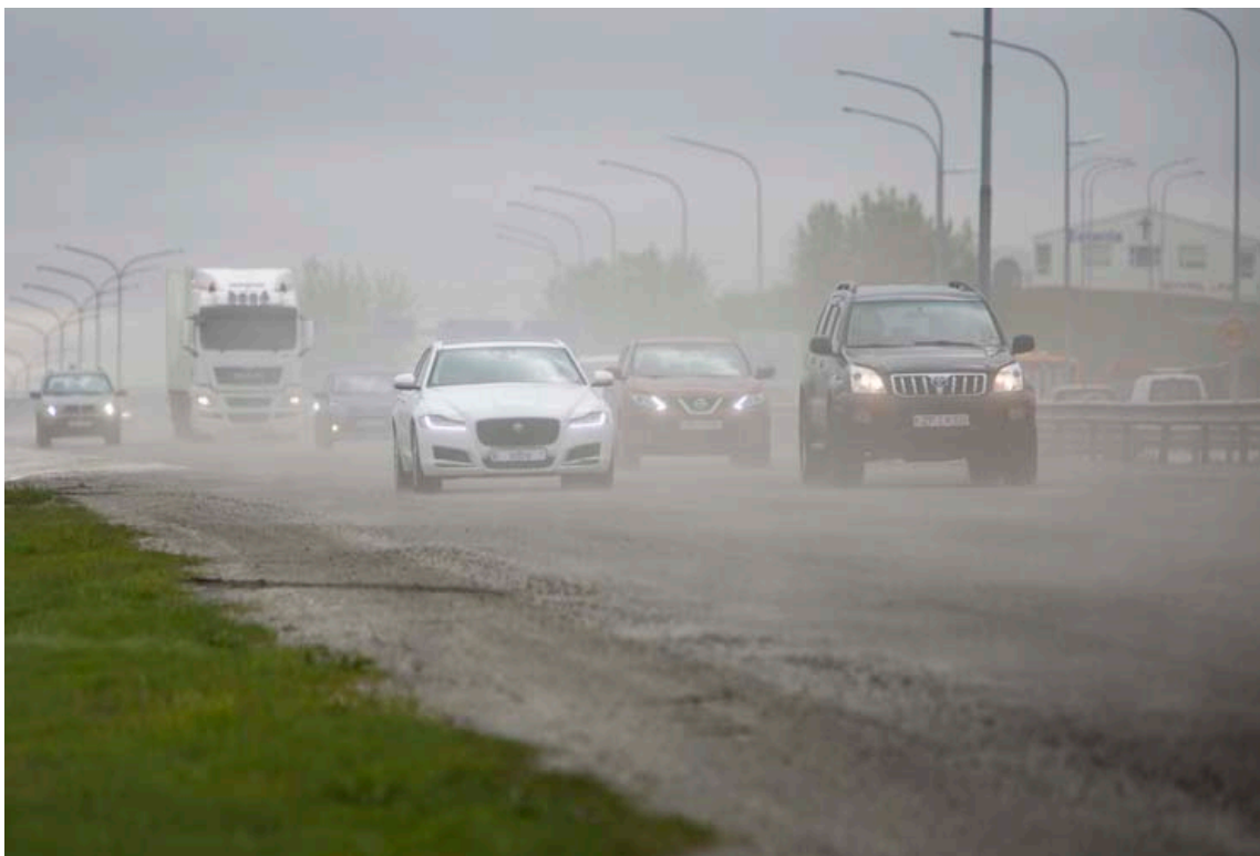
Unnið er að endurbótum á Vesturlandsvegi við Ártúnsbrekku og vegurinn var fræstur upp í fyrrinótt. Við það myndaðist mikill ryksveimur sem lagðist yfir bíla þar í brekkunni og austur eftir þangað sem horft er á myndinni. Vegageröin stendur fyrir framkvæmdunum. FRÉTTABLAÐIÐ/ERNIR
