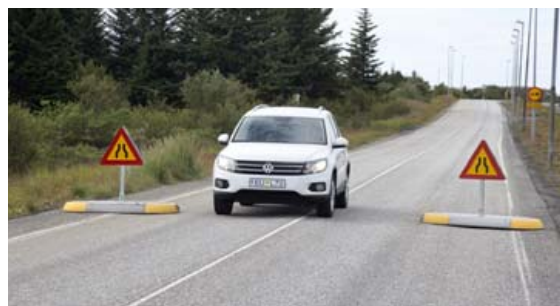
Aka þarf yfir öbrotna línu á miðjum Álftanesvegi til að komast fram hjá nýjum hraðahindrunum. FRÉTTABLAÐIÐ/STEFAN
