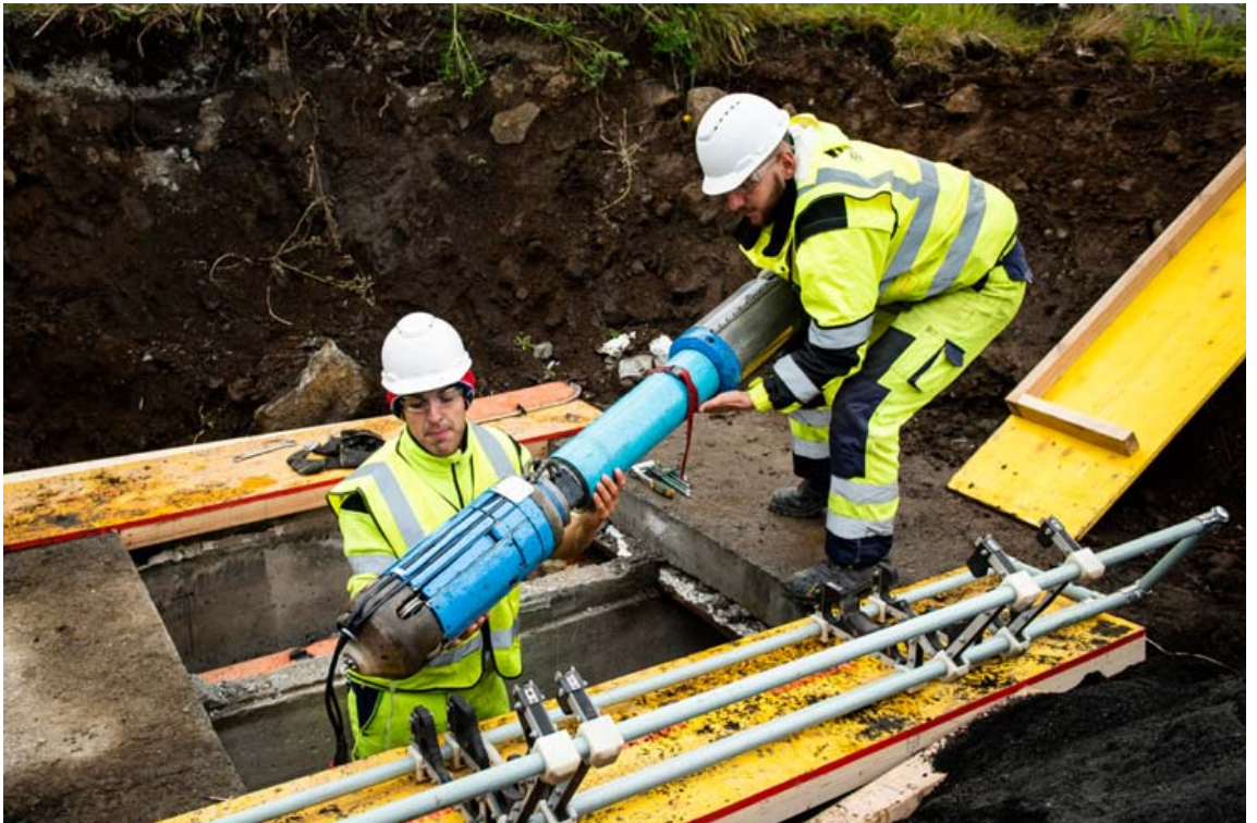
Rússneskur dvergkaftáttur er nú látinn rannsaka innra byrði á vatnslögnum borgarinnar, eins og hér nærri Árbæjarstíflu. Rússneskir sérfræðingar frá norska fyrirtækinu Breivoll skima nokkrar af aðalæðum hitaveitukerfisins. „Við erum engar niðurstöður búin að fá enn þá. Það eru teknar myndir og það sem við höfum séð af þeim litur þökkalega út,“ sagði Ólöf Snæhólm Baldursdóttir, upplýsingafulltrúi Veitna, í gærkvöldi. FRÉTTABLAÐIÐ/SIGTRYGGUR ARI
