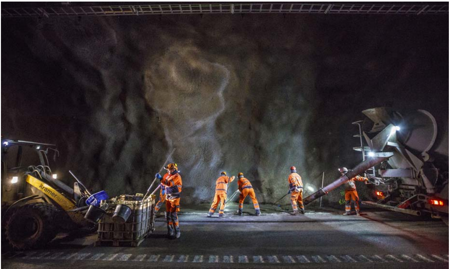
Ef allt gengur að öskum er ekki útséð um að hægt verði að opna Vaðlaheiðargöng í desember að sögn Valgeirs Bergmann, framkvæmdastjóra Vaðlaheiðarganga. Verkamenn unnu hörðum höndum við að steypa vegaxlir í göngunum þegar ljósmyndara Fréttablaðsins bar að. Opnun ganganna yrði kærkomin jölagjöf fyrir íbúa á Norðurlandi. FRÉTTABLAÐIÐ/AUÐUNN
