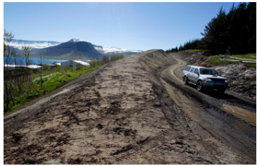
Frá byggingu snjóflóðavarnar á Ísafjörði. FRÉTTABLAÐIÐ/PJETUR
