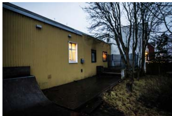
Nýtt tvíbýlishús á Bergstaðastræti 29 á að vera áfast þessum tveimur íbúðarhúsum og loka fyrir gluggana á gula húsinu. FRÉTTABLAÐIÐ/SIGTRYGGUR ARI
