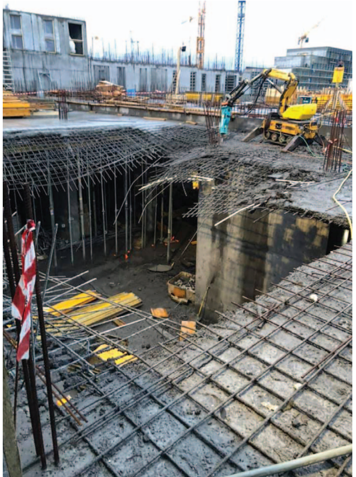
Fjarstýrður bor var notaður til að brjóta afganginn af gólfplötunni. Endurgera þarf alla plötuna. MYND/LÍNUBORUN
