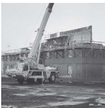
Íbúðablokkir í byggingu á Keflavíkurflugvelli árið 1992. MYND/ÆGIR MÁR KÁRASON
