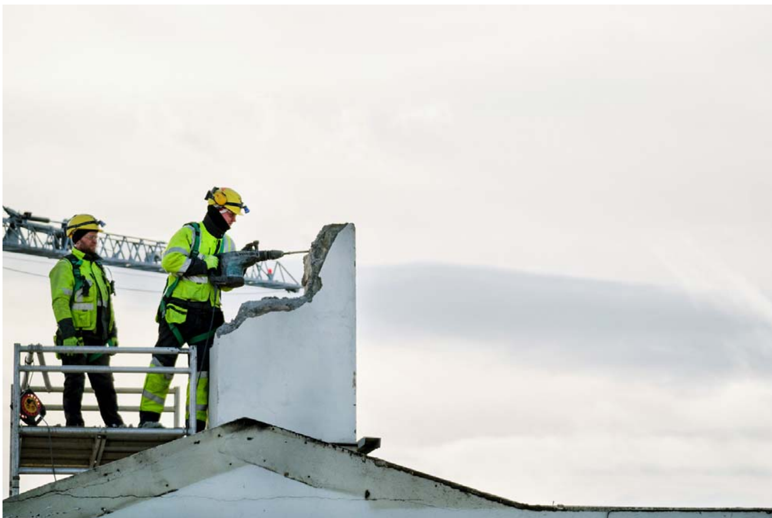
Þessir harðduglegu iðnaðarmenn héldu áfram niðurrifi gamla Landsímahússins við Austurvöll í miðborginni í gær. Verið var að rífa strompinn á húsinu þegar ljósmyndari Fréttablaðsins átti þar leið hjá í gær og má því segja að húsið sé loksins hætt að reykja. FRÉTTABLAÐIÐ/ANTON BRINK
