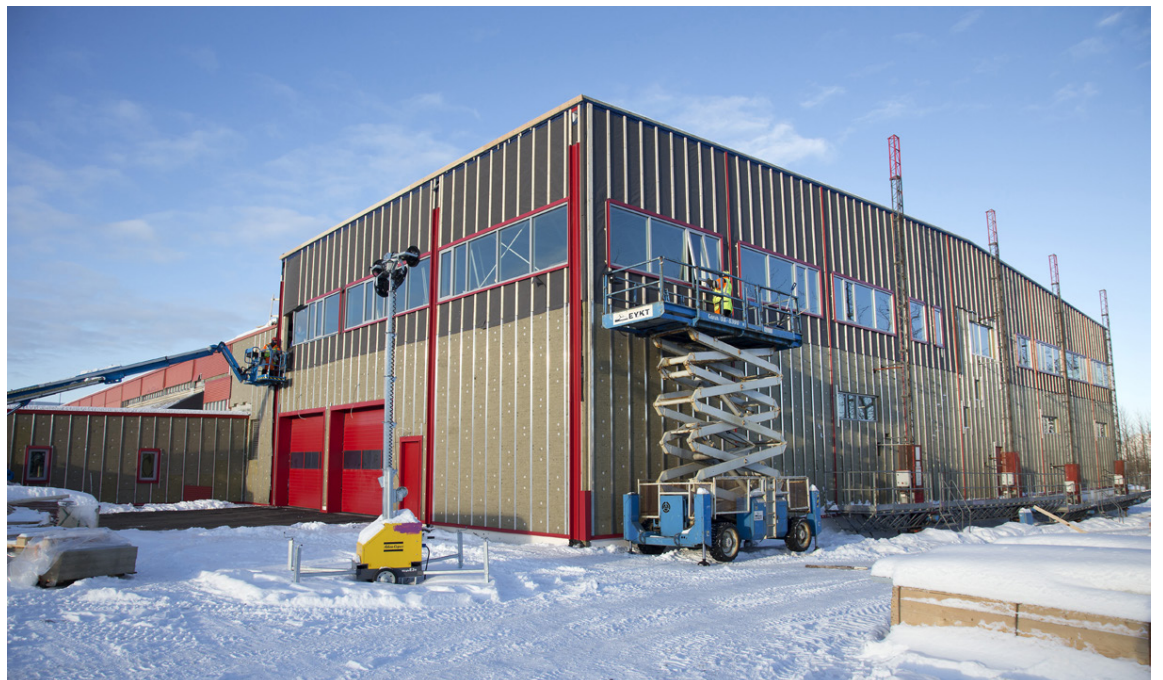
Miklir fjármunir fóru í viðbyggingu við flutningamiðstöð Póstsins að Stórhöfða. FRÉTTABLAÐIÐ/STEFAN
