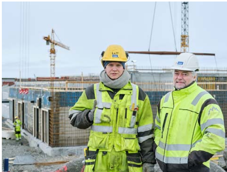
Lárus og Árni Geir við nýbyggingu Sorpu í Álfsnesi. MYND/ANTON BRINK
