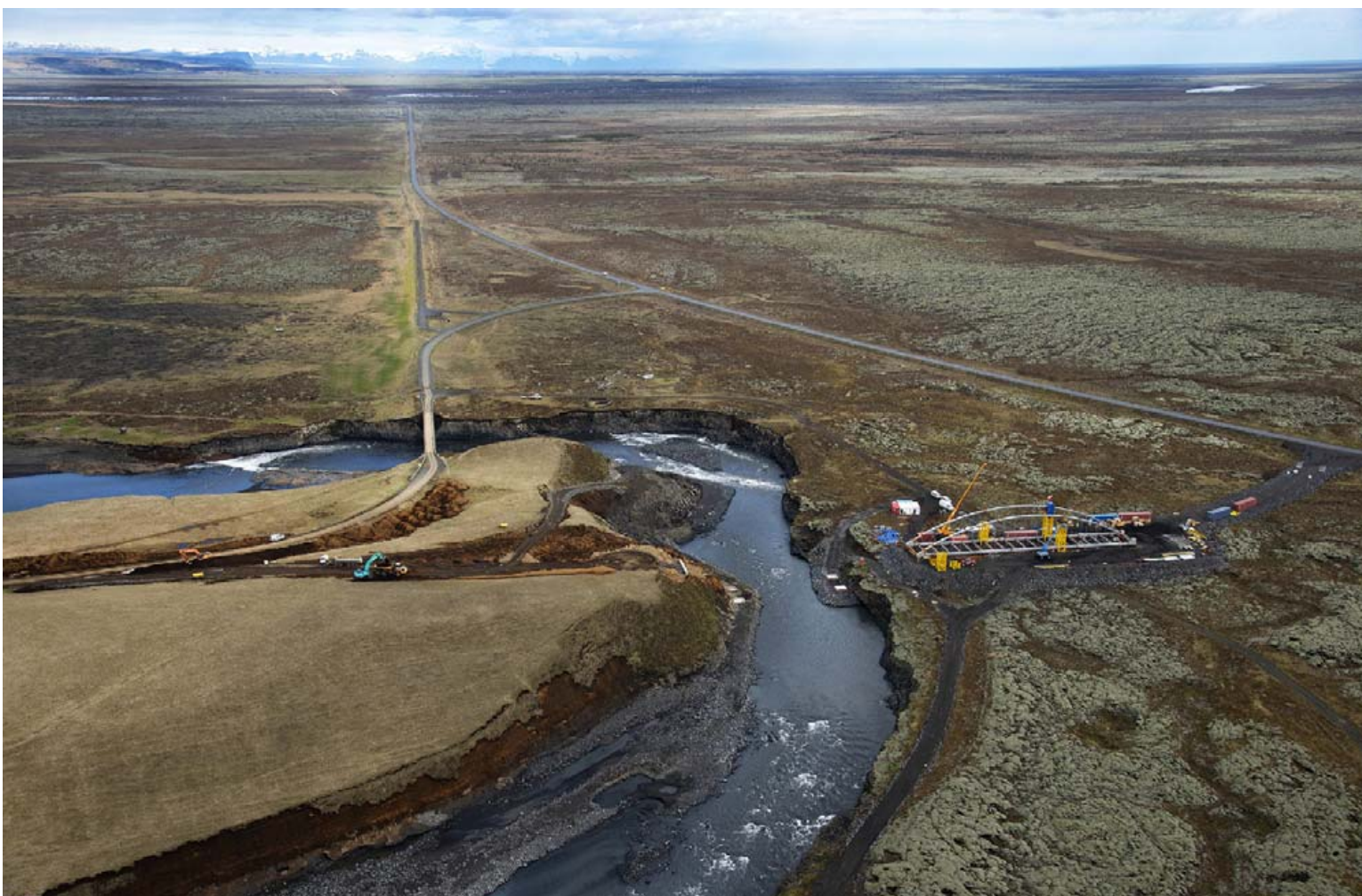
Stefnt er á að ný brú yfir Eldvatn í Skaftártungu verði tekin í notkun í lok sumars. Eins og sjá má á þessari mynd sem Haukur Snorrason tók eru framkvæmdir nú í fullum gangi en sjálf brúin er smíðuð í Póllandi. Nýja brúin er stálbogabrá með steypu brúargólfi. MYND/HAUKUR SNORRASON
