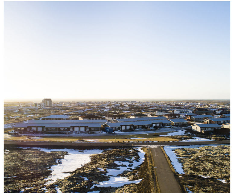
Starfsmenn Grindavíkurbæjar eru verðlaunaðir með gjafabréfi vegna góðrar afkomu bæjarins og aðhalds sem sýnt var í fjármálum. FRÉTTABLAÐIÐ/ERNIR
