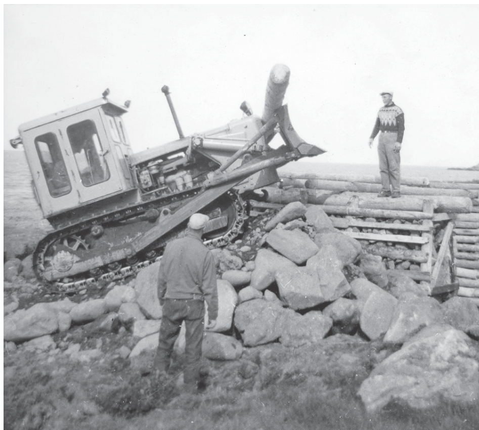
Brúargerð við Skarfadalsá á Strandavegi í Veiðileysufirði árið 1966. MYND/JÓN J. VÍÐIS
