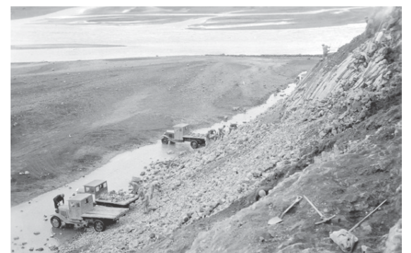
Gerð varnargarðs vegna brúargerðar við Markarfljót í Rangárvallasýslu árið 1933. MYND/VEGAGERÐIN
