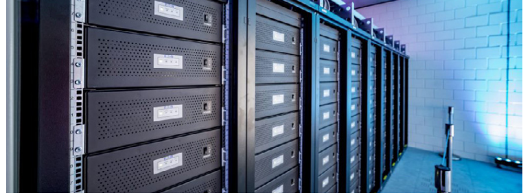
Stæða af rafhlöðum úr Leaf bílum knýr nú rafmagnsþörf Amsterdam Arena.
