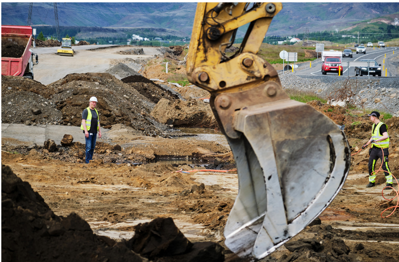
Breikkun stendur yfir á hringvegi 1, á kaflanum á milli Hveragerðis og Selfoss. Samkvæmt Vegagerðinni hefur verið góður gangur í framkvæmdunum en inni í þeim er einnig breikkun Varmárbrúar. Hluti vegarins er lokaður en hjáleid var opnuð fyrir umferð í maí. FRÉTTABLAÐIÐ/ANTON BRINK
