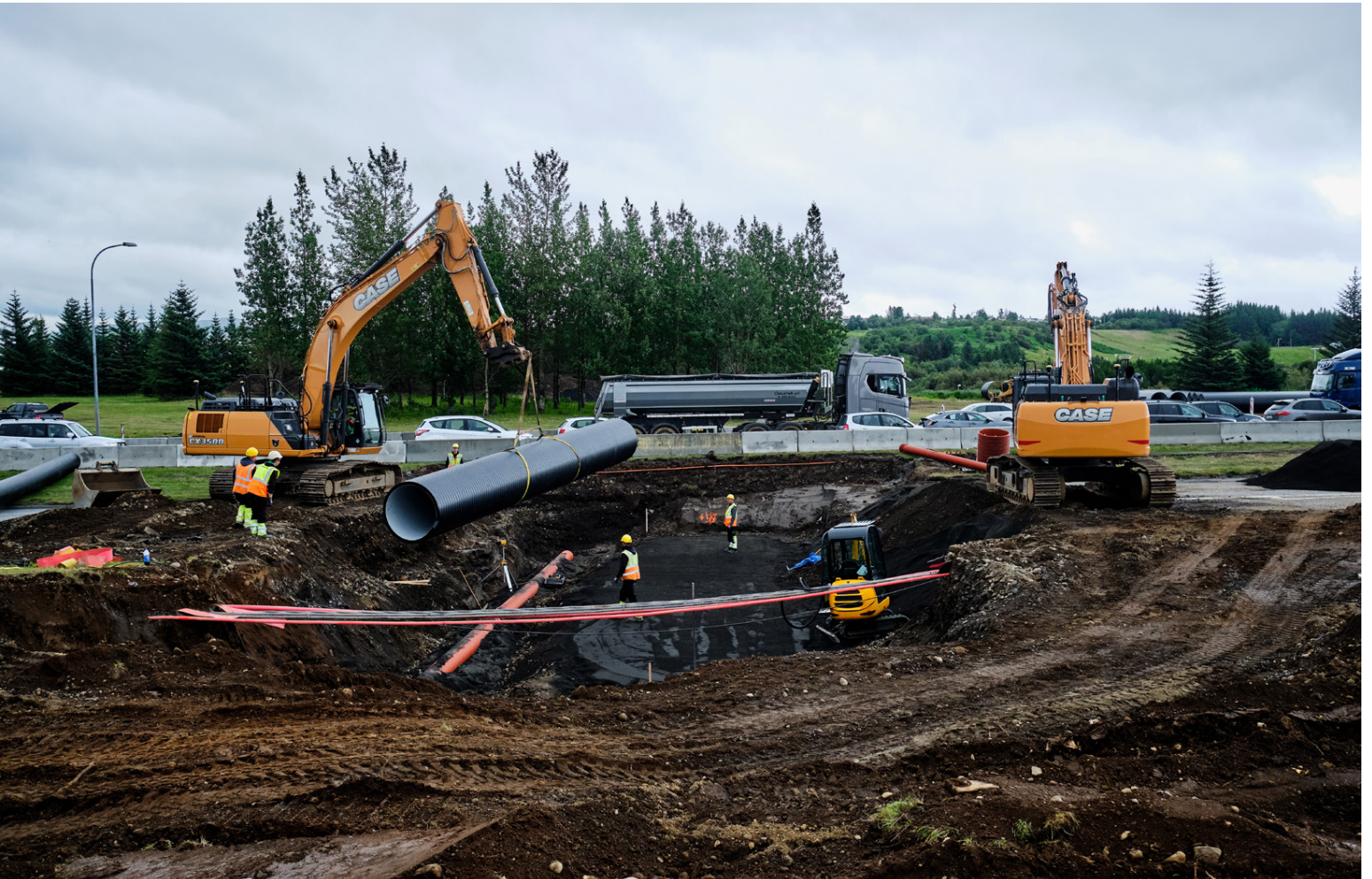
Unnið er að endurnýjun lagna Veitna frá Reykjanesbraut við Sprengisand um Elliðaárdal og upp með Rafstöðvarvegi. Er þar um að ræða fráveitugagnir, kaldavatnslagnir, hitaveitugagnir, raflagnir ásamt fjarskiptalögnum Gagnaveitu Reykjavíkur og Mílu. FRÉTTABLAÐIÐ/ANTON BRINK
