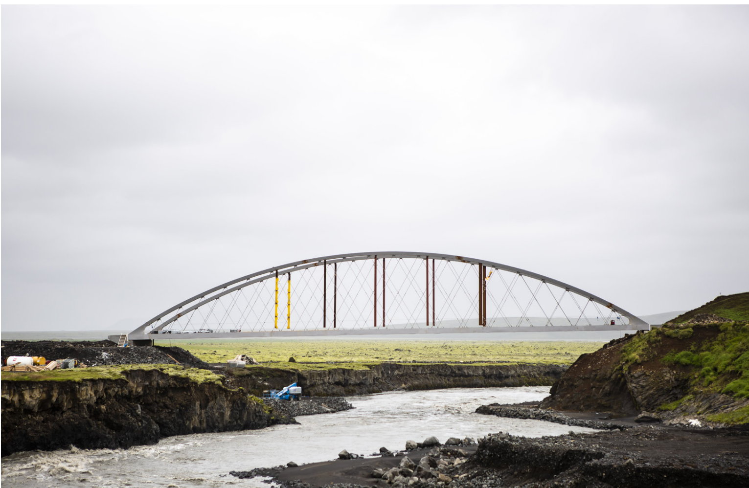
Brúin yfir Eldvatn hjá Ásum í Skaftártungu skemmdist verulega í Skaftárhlaupi árið 2015. Nú stendur yfir vinna við uppbyggingu nýrrar brúar yfir vatnið. Til stendur að vígja brúna í lok sumars. Brúin er með fristandandi stálbogum og tekur sig vel út í landslaginu. FRÉTTABLAÐIÐ/ERNIR
