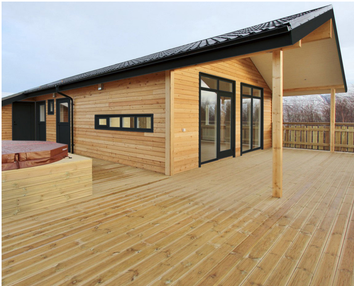
Hér sést nýjasta húsið uppsett og tilbúið. Þetta er 107m 2 hús, rúmgott og fallett.
