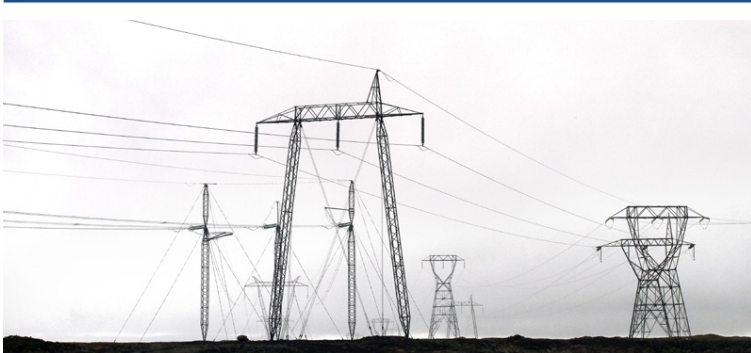
Lagning nýrra raflina krefst umhverfismats. Hér sést raforkuflutningskerfi Landsnets við Hellisheiðarvirkjun í Hverahlíð. FRÉTTABLAÐIÐ/STEFÁN
