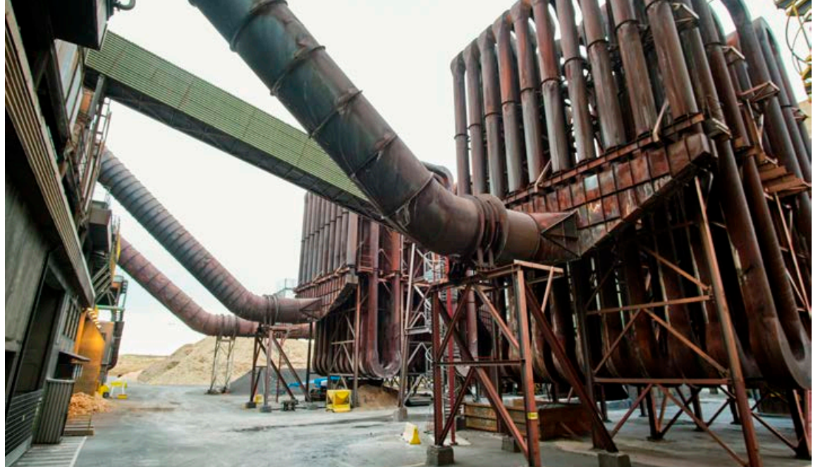
Mögulegt er að endurheimta 70-80 MW af varmaorku sem fer til spillis við framleiðsluna. FRÉTTABLAÐIÐ/ANTON BRINK
