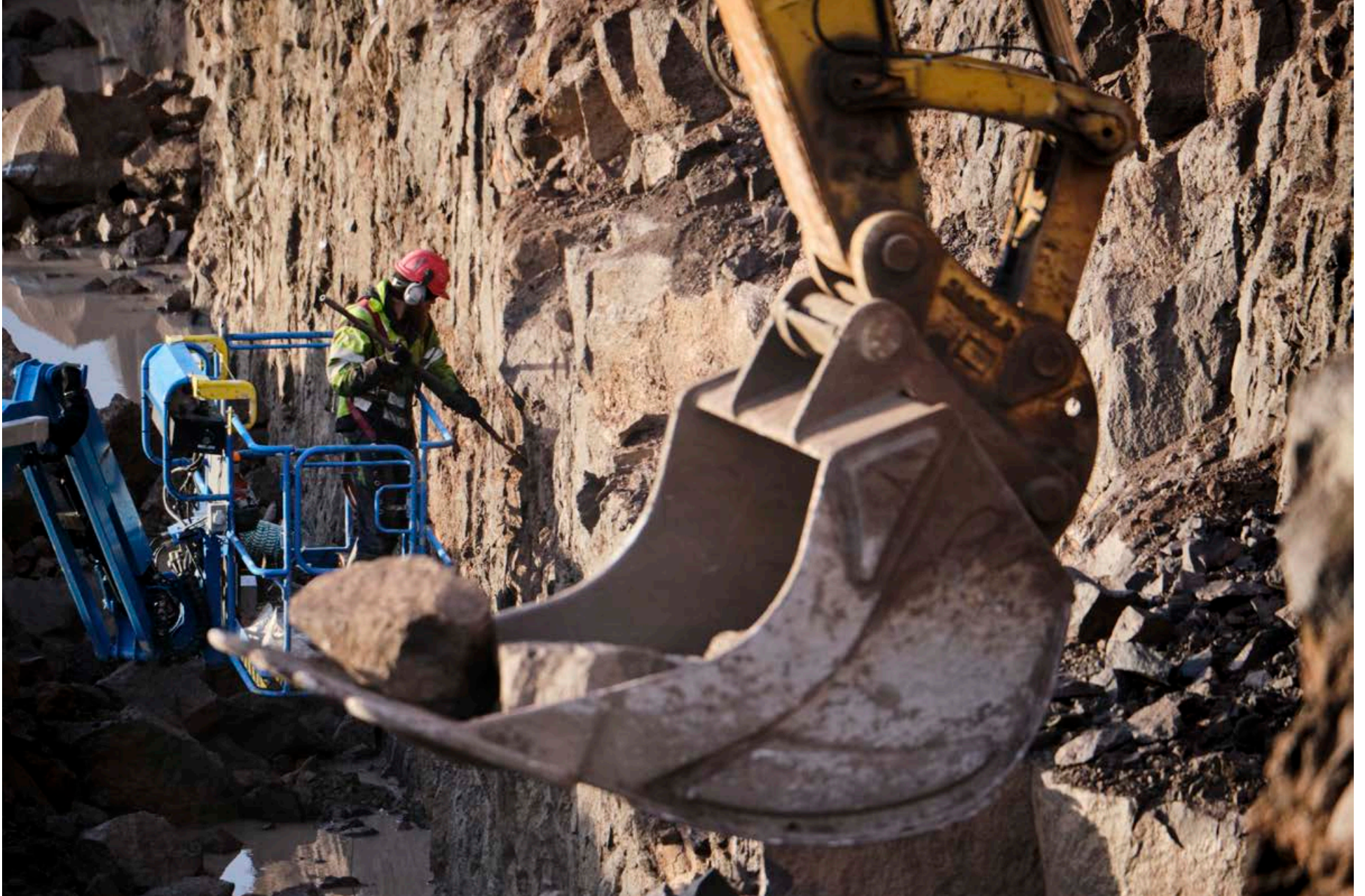
Miklar framkvæmdir með stórvirkum vinnuvélum standa yfir á Hringbraut vegna nýbyggingar þjóðarsjúkrahúss. Í gær var í gangi sprengivinna og jarðvegsframkvæmdir í grunni nýs meðferðarkjarna spítalans. Framkvæmdasvæði meðferðarkjarnans er nú komið í fulla stærð og unnið er að uppgreftri og bergstyrkingum á norðurvegg kjarnans. FRÉTTABLAÐIÐ/ANTON BRINK
