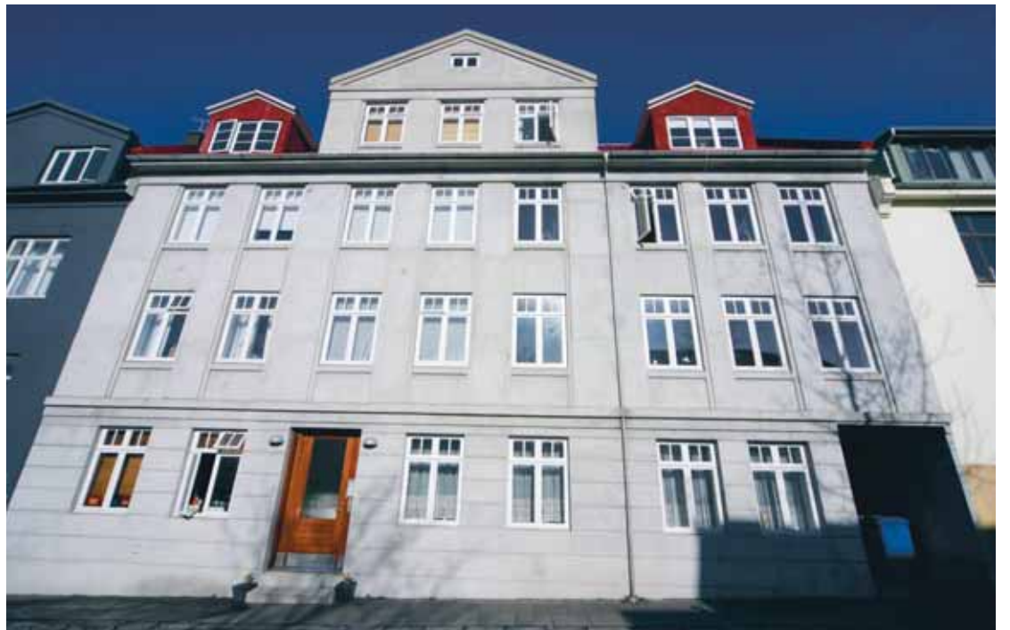
Húsið var byggt árið 1922. Framhlið þess hefur verið tekin í gegn og gluggarnir færðir í upprunalegt horf.
