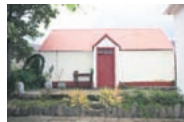
Húsið hefur verið íbúðarhús og fjós.
