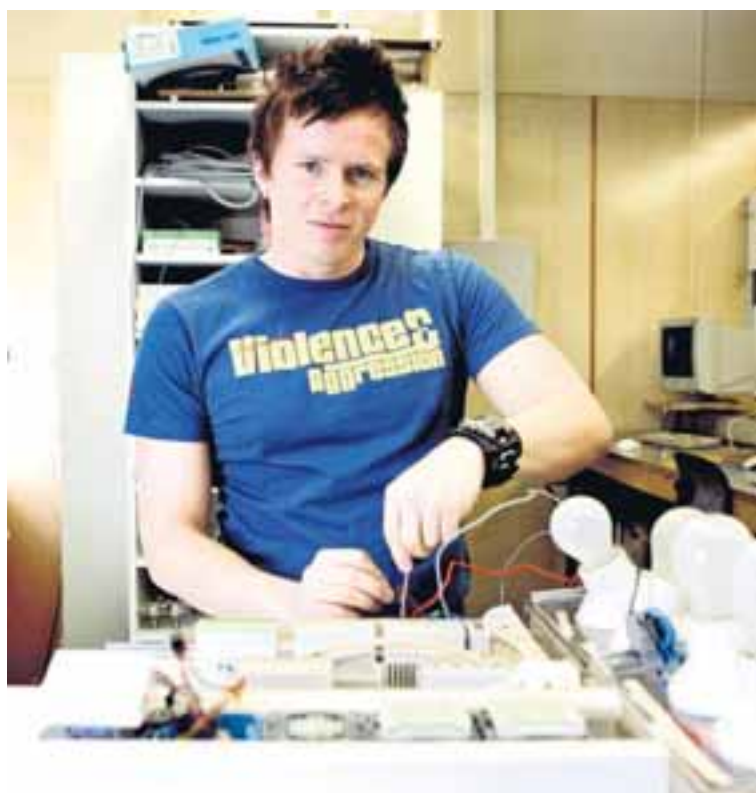
Skúli Skúlason er að útskrifast í rafvirkjun frá Iðnskólanum í Reykjavík. Á myndinni sést hann tengja ljós við svokölluð instabus-kerfi sem njóta mikilla vinsælda.
