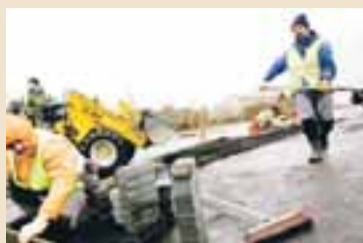
HRINGBRAUT FÆRD Starfsmenn Háfells að helluleggja við Hringbraut í byrjun árs 2006. Færsla Hringbrautar er eitt stórra verkefna sem fyrirtækið hefur tekið að sér.
