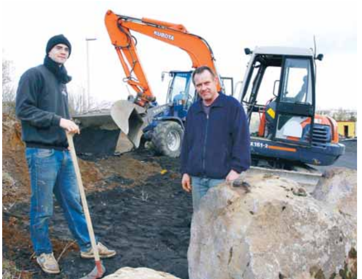
Bjarki Már Gunnarsson og Gunnar Gunnarsson voru að hlaða stórgrýtiskant á lóðarmörkum. Til hjálpar eru Volvo-framskófluvélar sem notaðar eru í jarðvinnu á sumrin og snjómokstur á veturna og Kubota-belta-grafa með tönn sem nýtist vel til að hlaða grjótinu upp.
