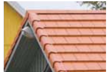
Ýmsir fylgihlutir fylgja þakskífum því sérstakur steinn fer á mæninn og þakbrúnirnar.
