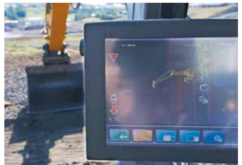
Mælingamenn eru að verða óþarfir á byggingarsvæðum þar sem GPS-búnaður er í sumum af nýjustu vinnuvélum.
