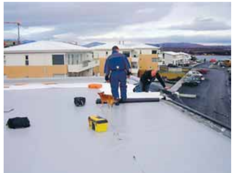
Þakdúkur er lagður á flöt þök og þök sem hafa minni halla en fjórtán gráður.
