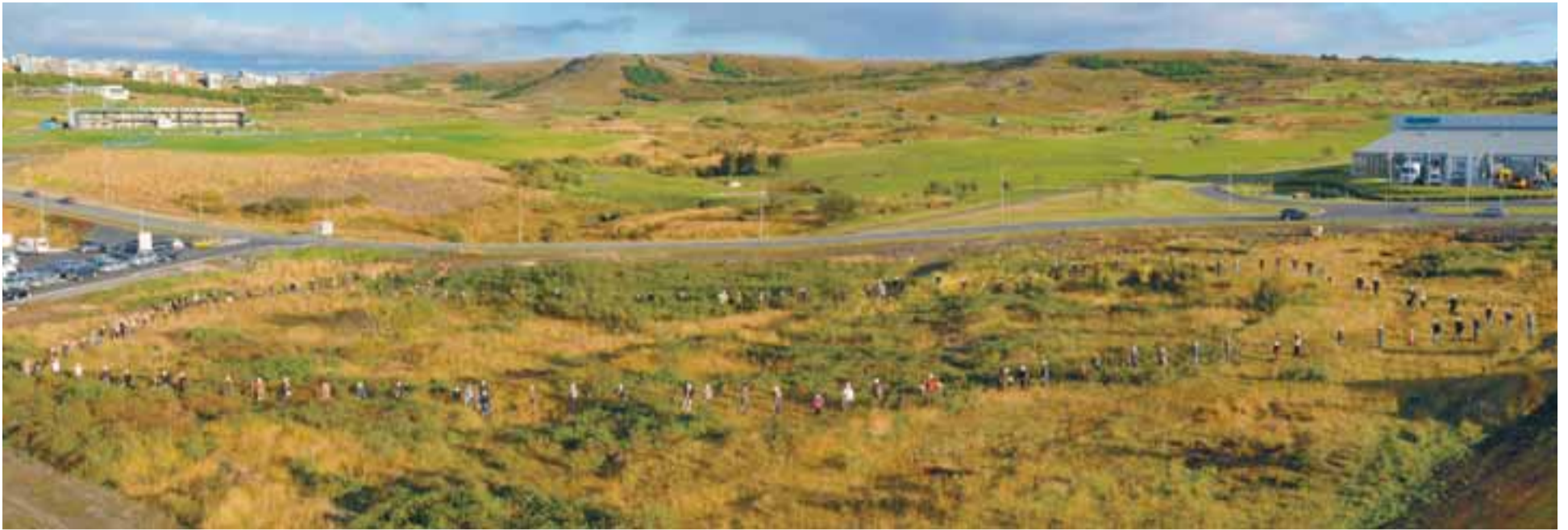
Starfsfólk Bílabúðar Benna og fjölskyldur þeirra röðuðu sér eftir útlínunum nýrrar byggingar fyrirtækisins og tóku fyrstu skóflustunguna.
