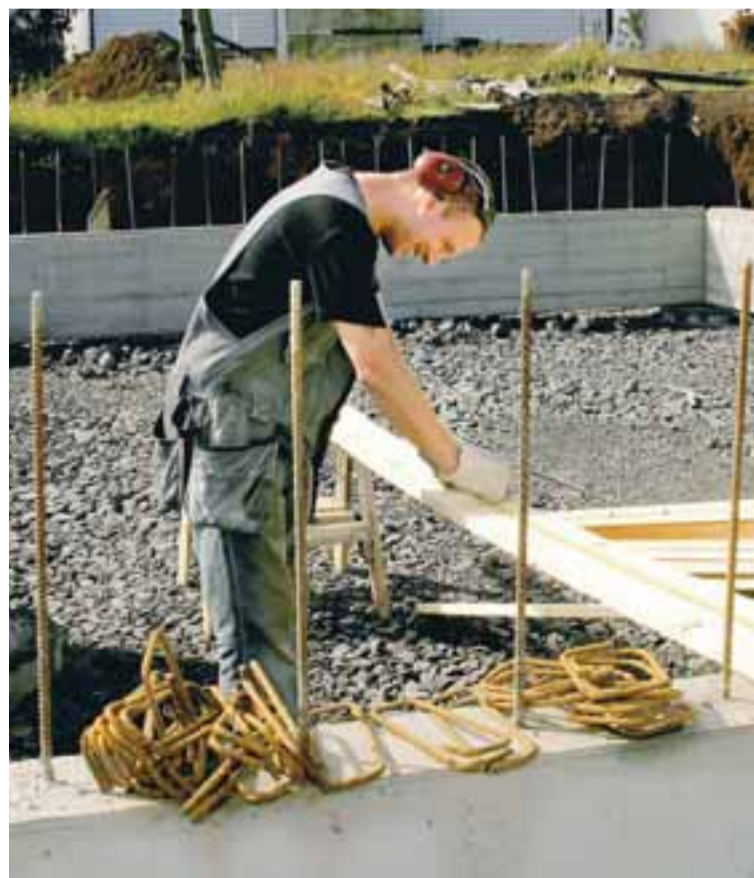
UNNIÐ Í GRUNNINUM Byggingaverktakar eru bjartsýnir á árið og segja yfirleitt að ekkert lát sé á verkefnum, þótt dregið hafi úr íbúðabyggingum.
