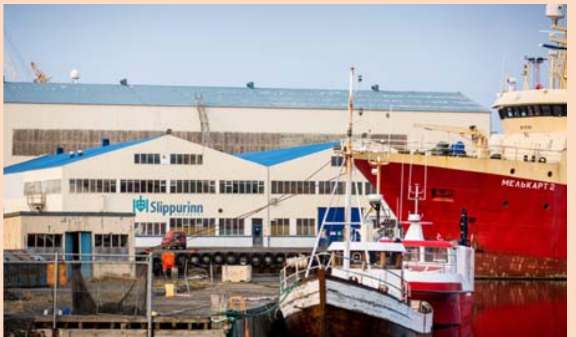
FYRIRTÆKIÐ Slippurinn Akureyri er stærsta skipasmíða- og málmvinnslufyrirtæki á Íslandi.
