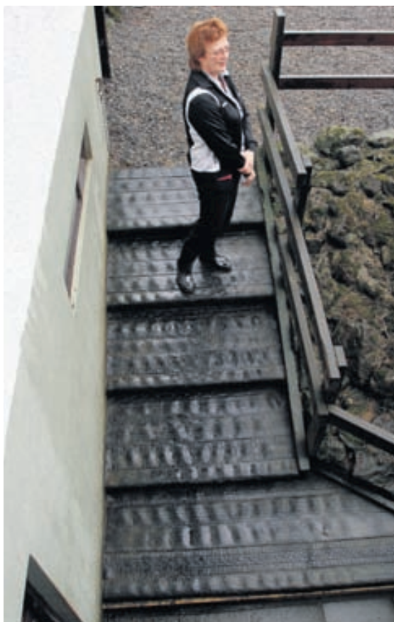
Tröppurnar upp úr kjallaranum eru lagðar dekkjagúmmíi svo íbúarnir þar eigi auðvelt með að fóta sig.
