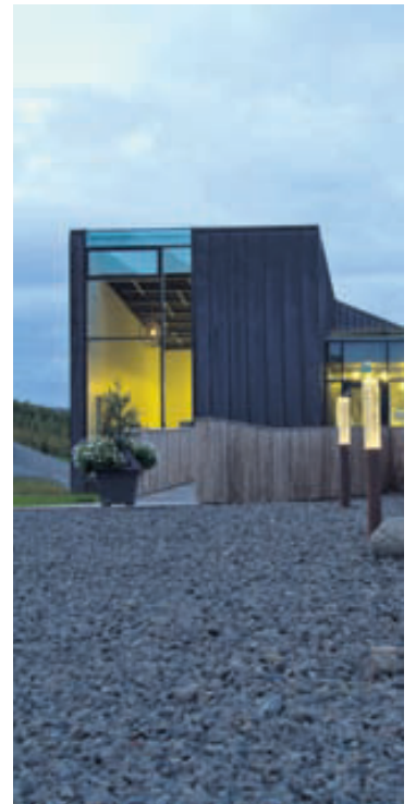
Geststofa á Skriðuklaustri úr smiðju Arkís. Gluggar og hurðir frá Gluggum ehf. MYNDRAFN SIG
