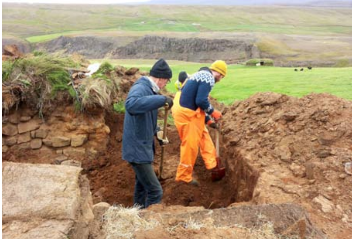
Unnið er að endurbyggingu útihúsa á Tyrningsstöðum í Skagafirði.
