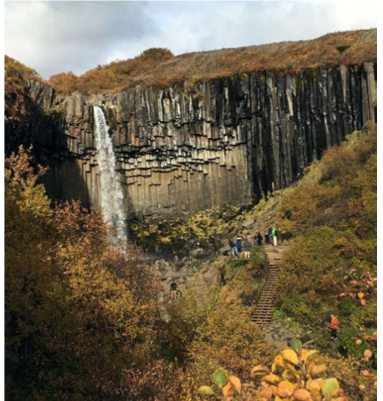
Útsýnispallur við Svartafoss í Skaftafelli. Pallurinn er innan í stuðlabergsskálinni, rétt við fossinn. Aðgengi fyrir vélar að fossinum er erfitt og var pallurinn smíðaður á verkstæði og fluttur með þyrlu á endanlegan stað. MYND/GUÐRÚN RAGNA
