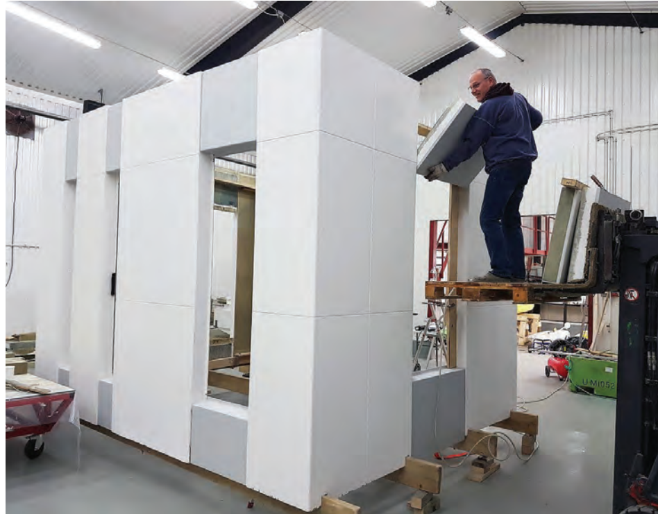
Regin Grímsson hefur fengið einkaleyfi á hugmyndinni, einingar úr gler- og koltrefjum með kjarna úr steinull. MYND/FIBRA
