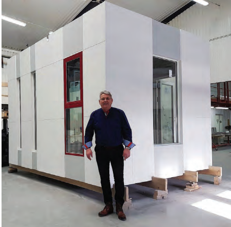
Regin Grímsson hefur fengið einkaleyfi á hugmyndinni, einingar úr gler- og koltrefjum með kjarna úr steinull. MYND/FIBRA
