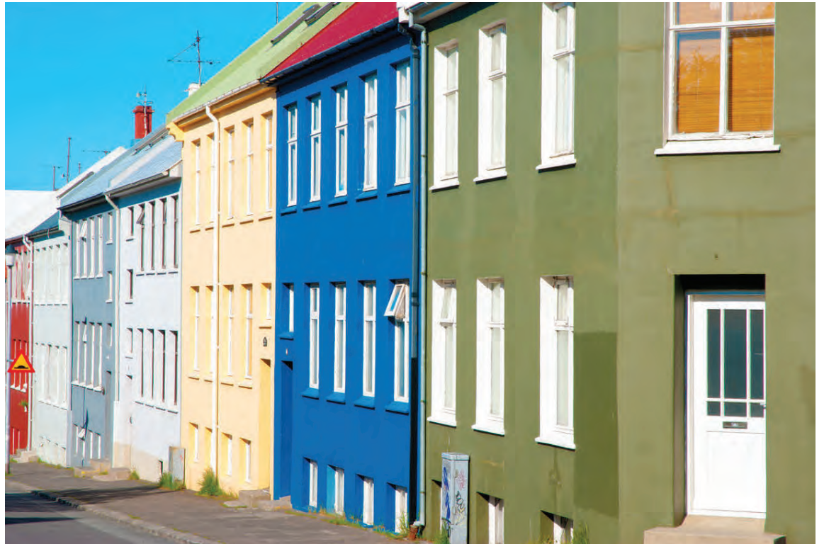
Viðhaldskerfi fasteigna er nýr kafli í öðru stærra tölvakerfi sem heitir BYGG-kerfið og margir þekkja.
