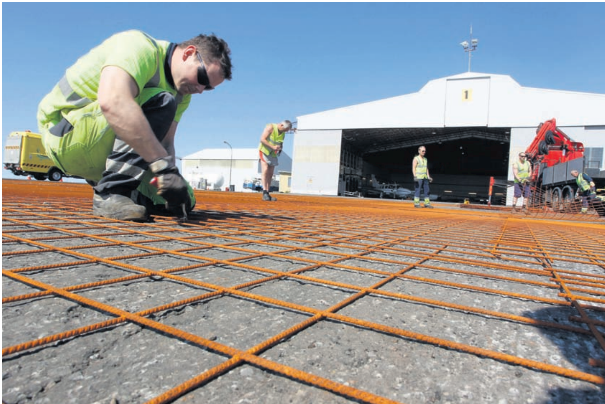
Unnið að viðgerð á Reykjavíkflugvelli. Járnet er lagt undir malbikið til að auka burðarþol.
