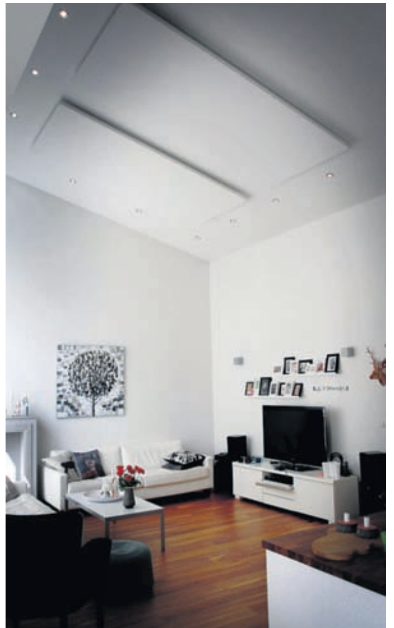
Ecophon Solo-plötur eru notaðar til að minnka glymjanda og hávaða. Þær eru settar upp með blindfestingum sem hleypa plötunni um 4 cm frá loftinu. Þessar plötur eru 1.200 x 2.400 mm.
