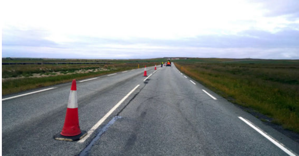
Unnið að sprunguviðgerðum á Vesturlandsvegi.
