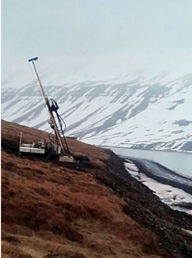
Jarðhitaleit í Sjúgandafirði vorið 2016. Borað undir þjóðveginn og út undir sjó til að leita að uppstreymi heita vatnsins.
