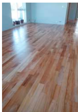
Slípað og lakkað gólf.
