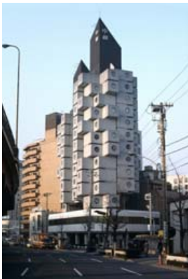
Nakagin Capsule Tower byggingin í Japan er frá árinu 1972 en arkitekt hússins er Kisho Kurokawa.
