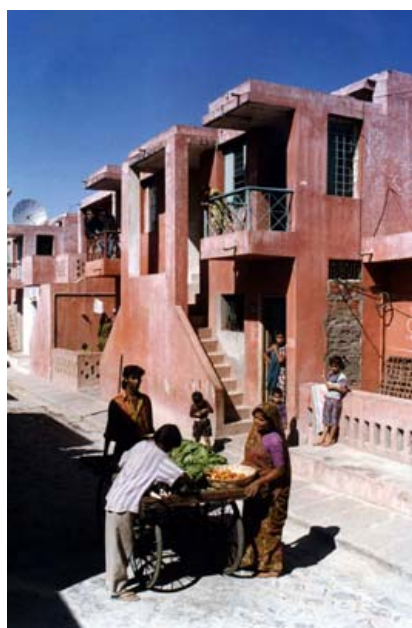
Húsnæði fyrir láglaunafólk í Aranya. Doshi er ávallt meðvitaður um umhverfi, menningu, sögu og sjálfbærni. Þannig hanna hann svalir, húsgarða og yfirbyggða gangstiga sem verja fólk fyrir sólinni.
