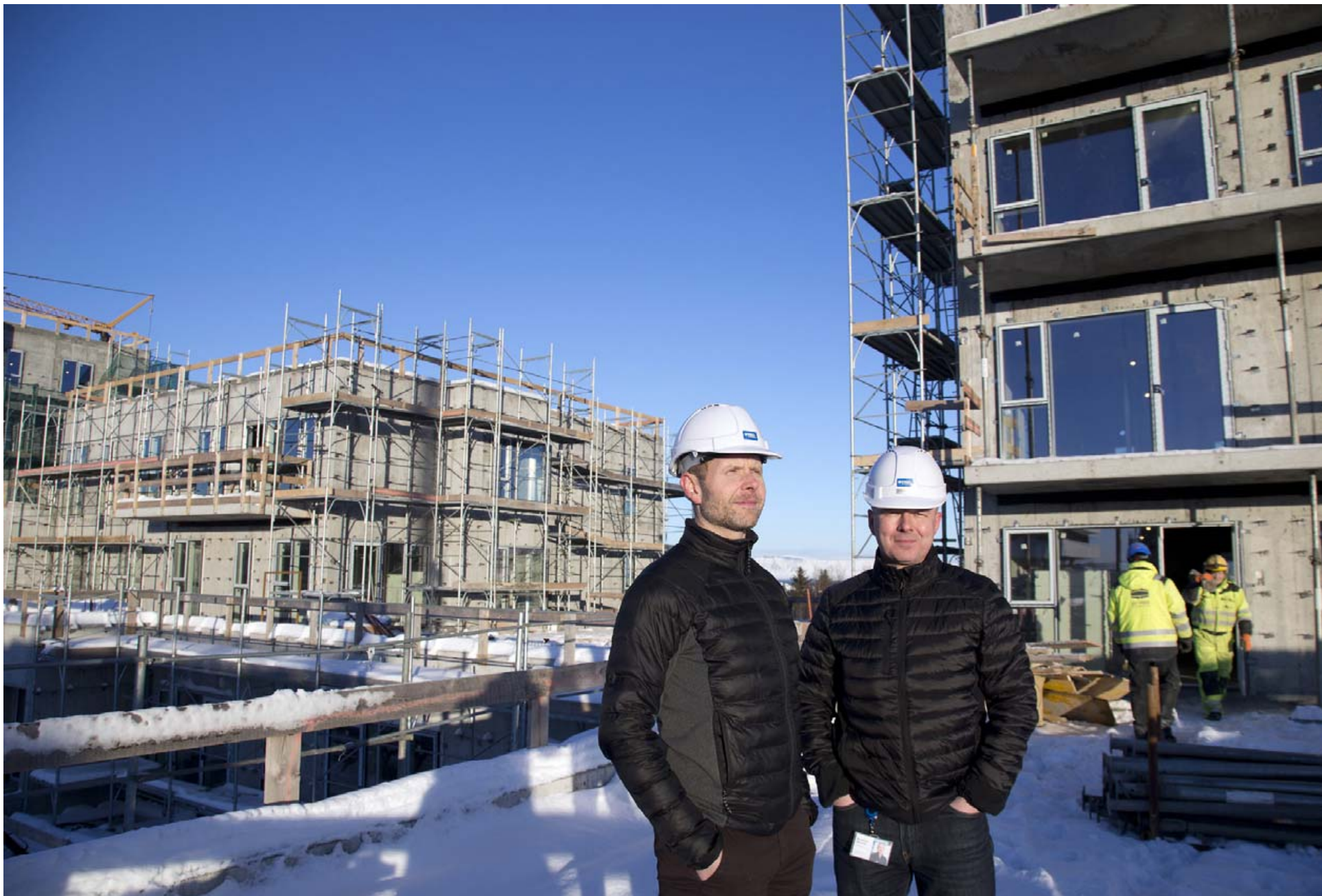
Sölustjórarnir Kjartan Long og Þorsteinn Lárusson, á verkstað á RÚV-reitnum þar sem BYKO er með ýmislegt á staðnum og koma heildarlausnir fyrir tækisins sér vel. FRÉTTABLAÐIÐ/STEFÁN
