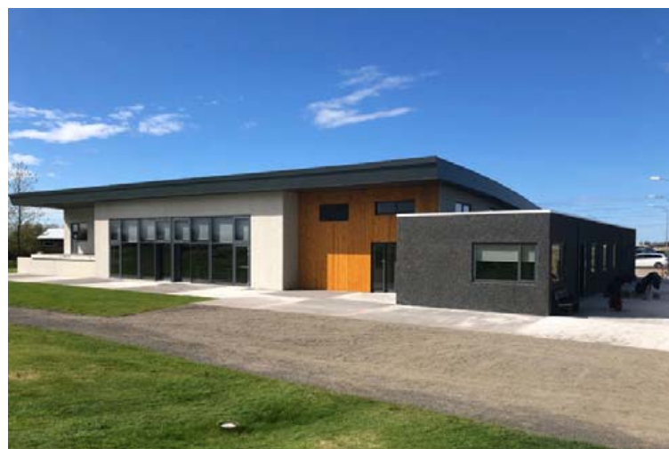
Ný frístundamiðstöð hýsir m.a. félagsaðstöðu Leynis, golfverslun, æfingaaðstöðu, veitingaaðstöðu og veislusal. MYND/AKRANESKAUPSTAÐUR
