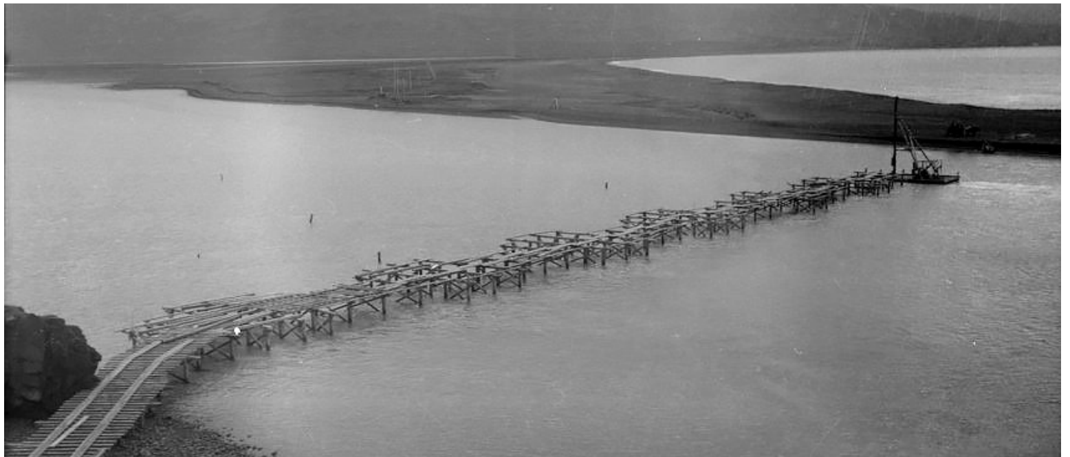
Brúargerð yfir vesturós Héraðsvatna árið 1925. Sennilega er langt komið að koma verkpöllum yfir ána en fyllt var út í farveginn að brúarendanum fjær að brúarsmið lokinni. Niðurrekstrartæki fyrir timburstaura í verkpalli við endann fjær. Fallhamarinn er sennilega á flotpramma og nokkurs konar undanfari verkpallasmiðarinnar. Á árbakkanum nær eru niðurrekstrarstaurar fyrir brúarstöplana, sem steyptir hafa verið á staðnum. FRÉTTABLAÐIÐ/GEIR ZOËGA
