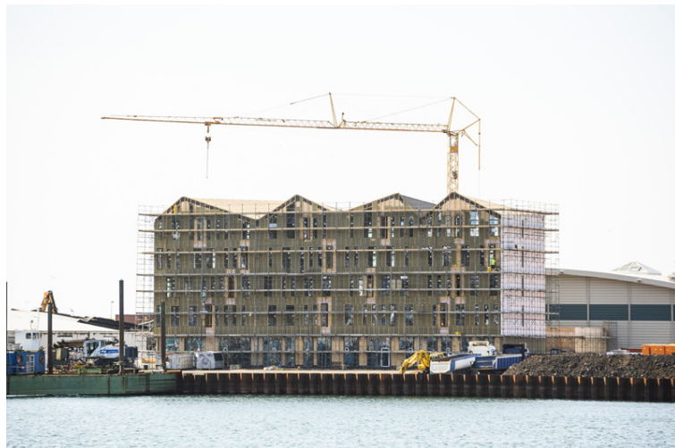
Þetta stóra fimm hæða hús í Hafnarfirði er alfarið úr CLT, meira að segja lyftugöng og stigar. Unnið er að því að klára að einangra og klæða húsið.
