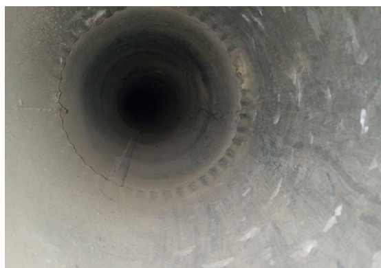
Það er hægt að anda léttar eftir að K2 kláraði verkið.
